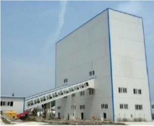
(a) 封闭式混凝土搅拌站
